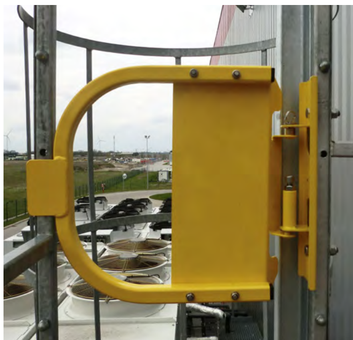
Mocowanie bramki AT 241 do słupków wsporczych AT 241 003
